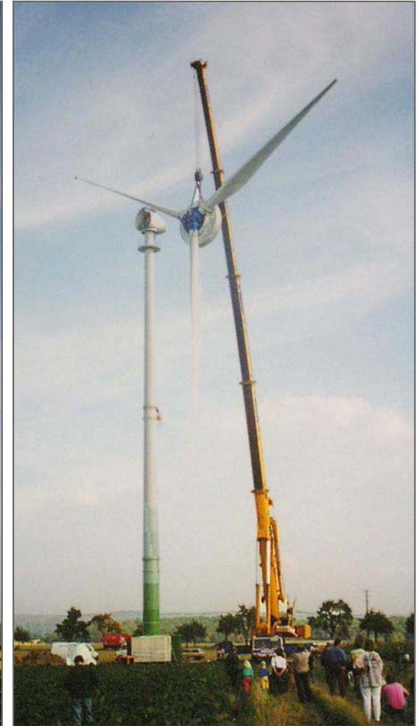
Inzwischen ist die Rotor- / Generator-Einheit montagebereit. Sie wird liegend angehoben und in der Luft in die Senkrechte gedreht. Mit zwei Halteseilen wird das Teil in die richtige Position gebracht.
