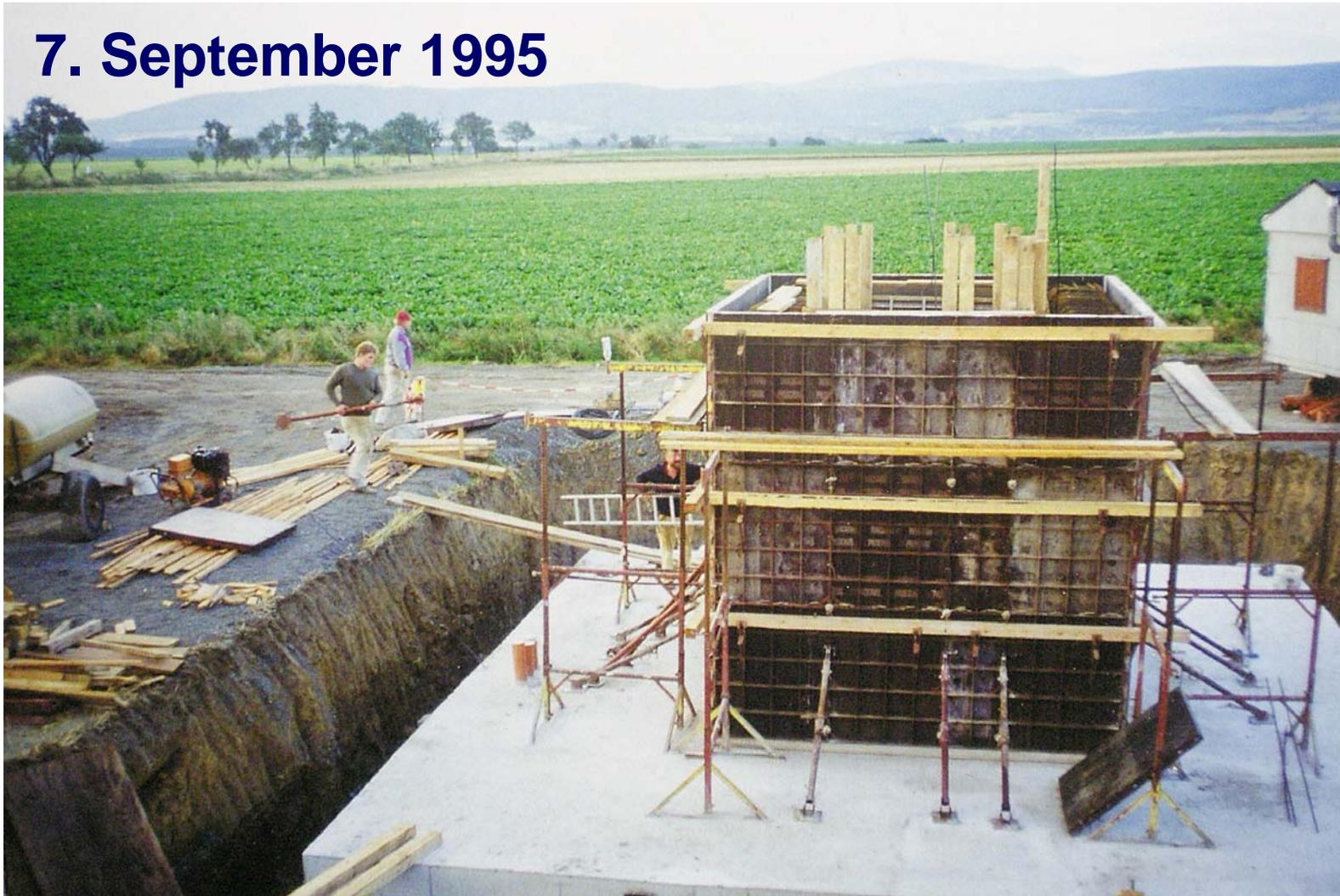
Der Köcher ist fertig eingeschalt. Die Schalung ist innen und außen mit Balken ausgesteift – der Beton kann kommen.
