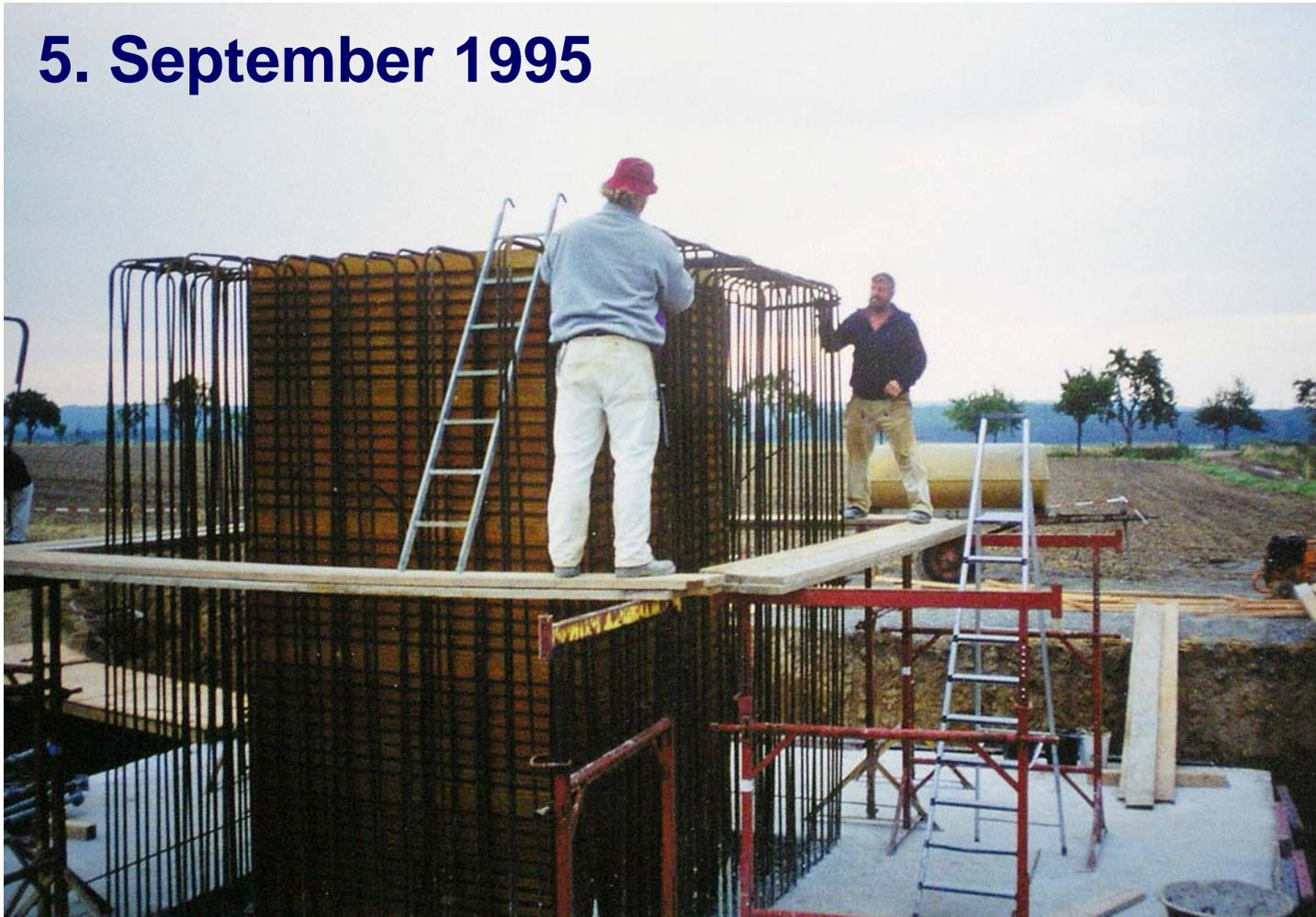
Per Kran ist die innere Schalung des KÖchers – ein eigens angefertigtes „Sickenrohr“ aus Eisenblech – eingesetzt worden. Das Gerüst für den Einbau der waagerechten Eisen steht. Jetzt kann die restliche Flechtarbeit erledigt werden.
