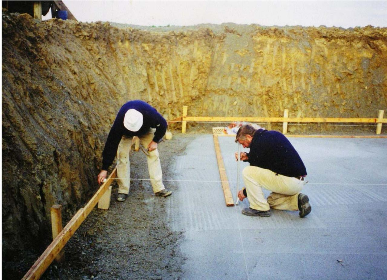
Die Sauberkeitsschicht ist nun abgebunden und begehbar. Die genaue Position des Fundaments wird eingemessen.
