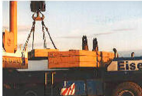
Bereits am Vortag der Turmaufstellung trifft der Kran ein: 20 Meter lang und 400 Tonnen Tragkraft. Zwei weitere Lastzüge transportieren Ausgleichsgewichte und Zubehörteile. Der Aufbau dauert mehrere Stunden.
