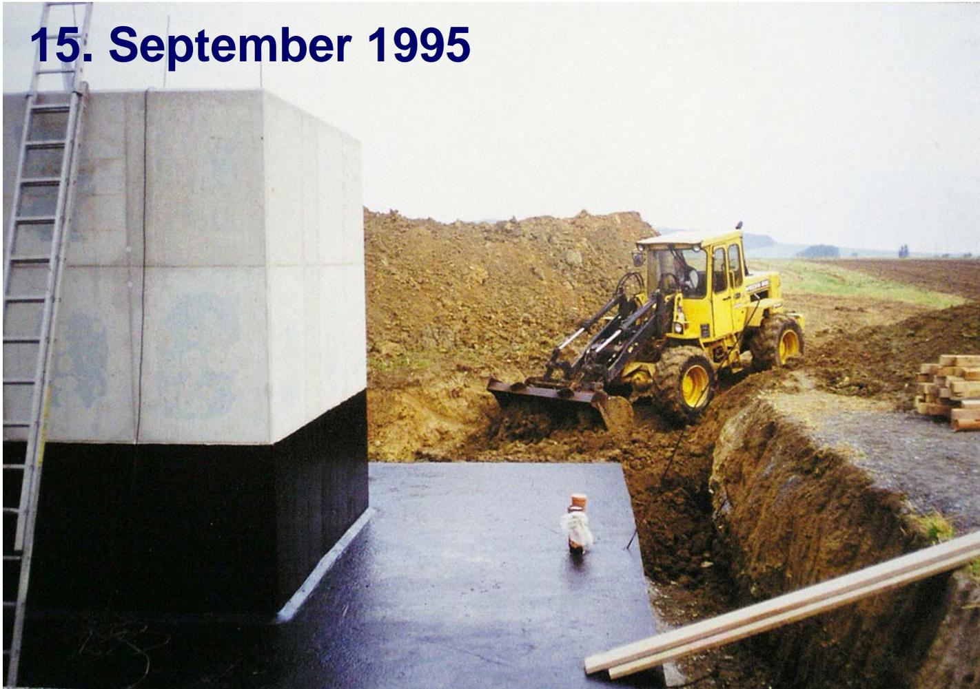
Der unterirdische Teil des Fundamentes ist mit einem Schutzanstrich versehen worden. Der Arbeitsraum wird nun lagenweise verfüllt und verdichtet. Im Köcher sind noch Feinarbeiten an den Leerrohren zu erledigen.
