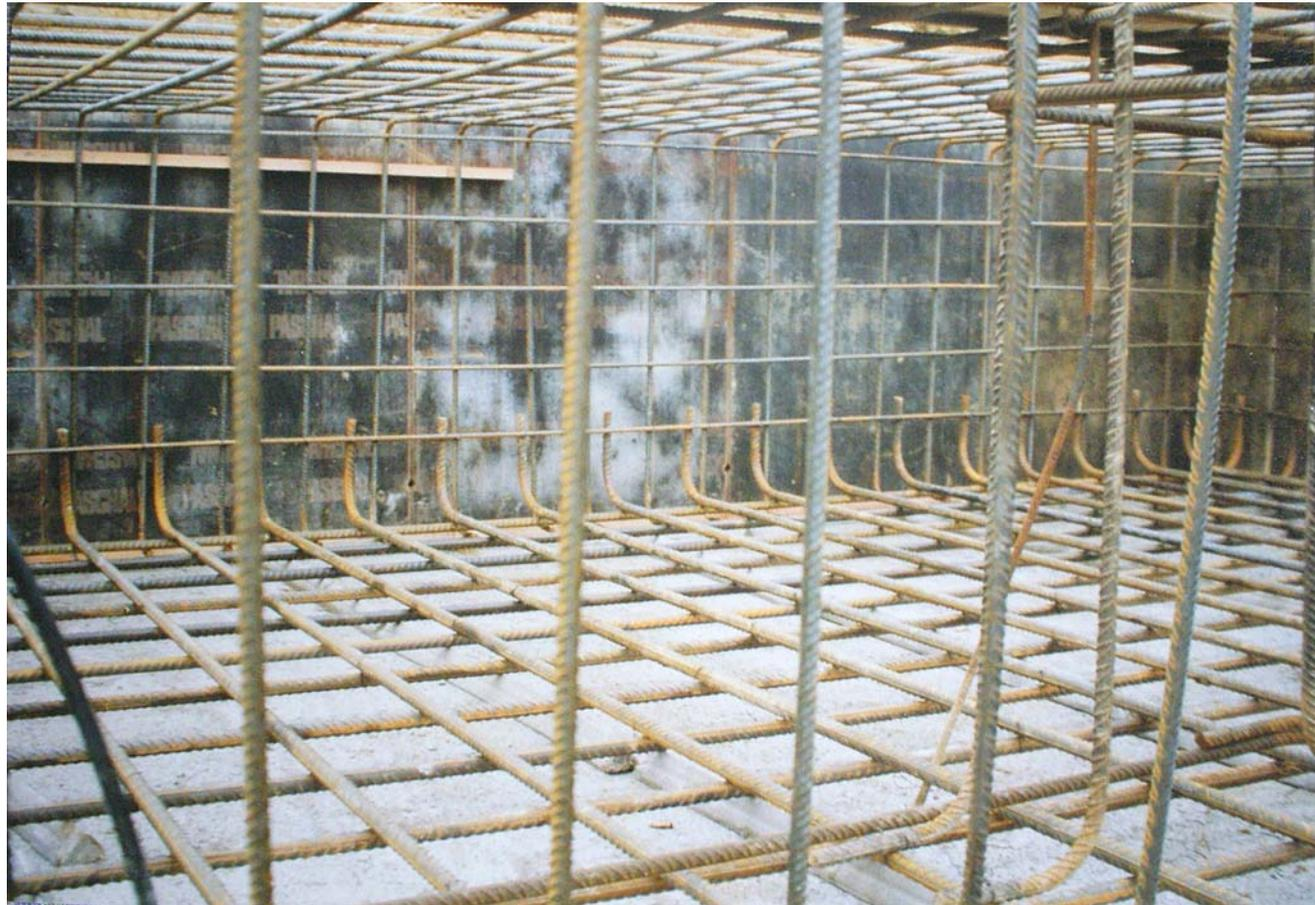
Die obere Bewehrung der Fundamentplatte ist fertiggestellt. Durch das enge Eisengeflecht ist ein regelrechter Käfig entstanden, der später die Zugkräfte im Fundament aufnimmt. Die für die Flechtarbeiten angebrachten Halteleiste (oben links) wird vor dem Guß wieder entfernt.
