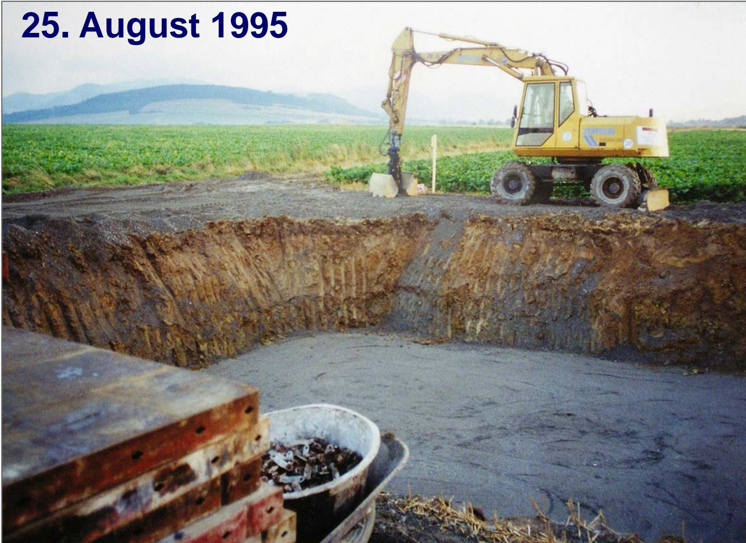
Unter Hochdruck ist der größte Teil des Mineralgemischs bis zum Wochenende eingebaut. Damit ist die empfindliche Baugrubensohle gegen Regen geschützt.
