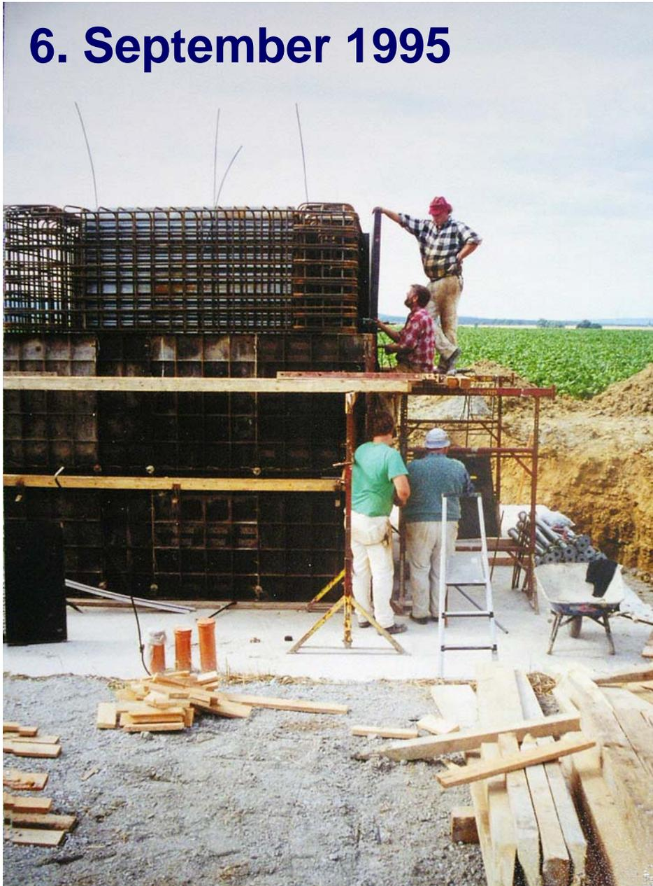
Das gesamte Eisen ist verbaut. Oben schauen die 4 Drähte heraus, mit denen der Turm geerdet werden soll. Ein guter Blitzableiter ist für den Schutz unserer Anlage sehr wichtig. Die Außenflächen des Köchers werden eingeschalt.
