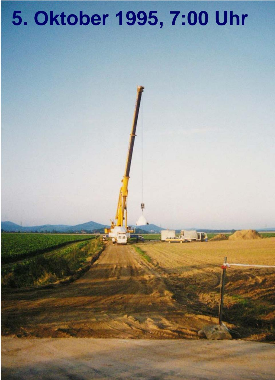
Die Baustelle ist bereit für die Aufstellung. Die erste Lieferung ist pünktlich eingetroffen: Maschinenhaus, Generator und Nabenverkleidung werden vom Tieflader gehoben und zur Montage bereitgestellt. Das Montageteam der Firma ENERCON steht in den Startlöchern – und das Wetter könnte nicht besser sein!
