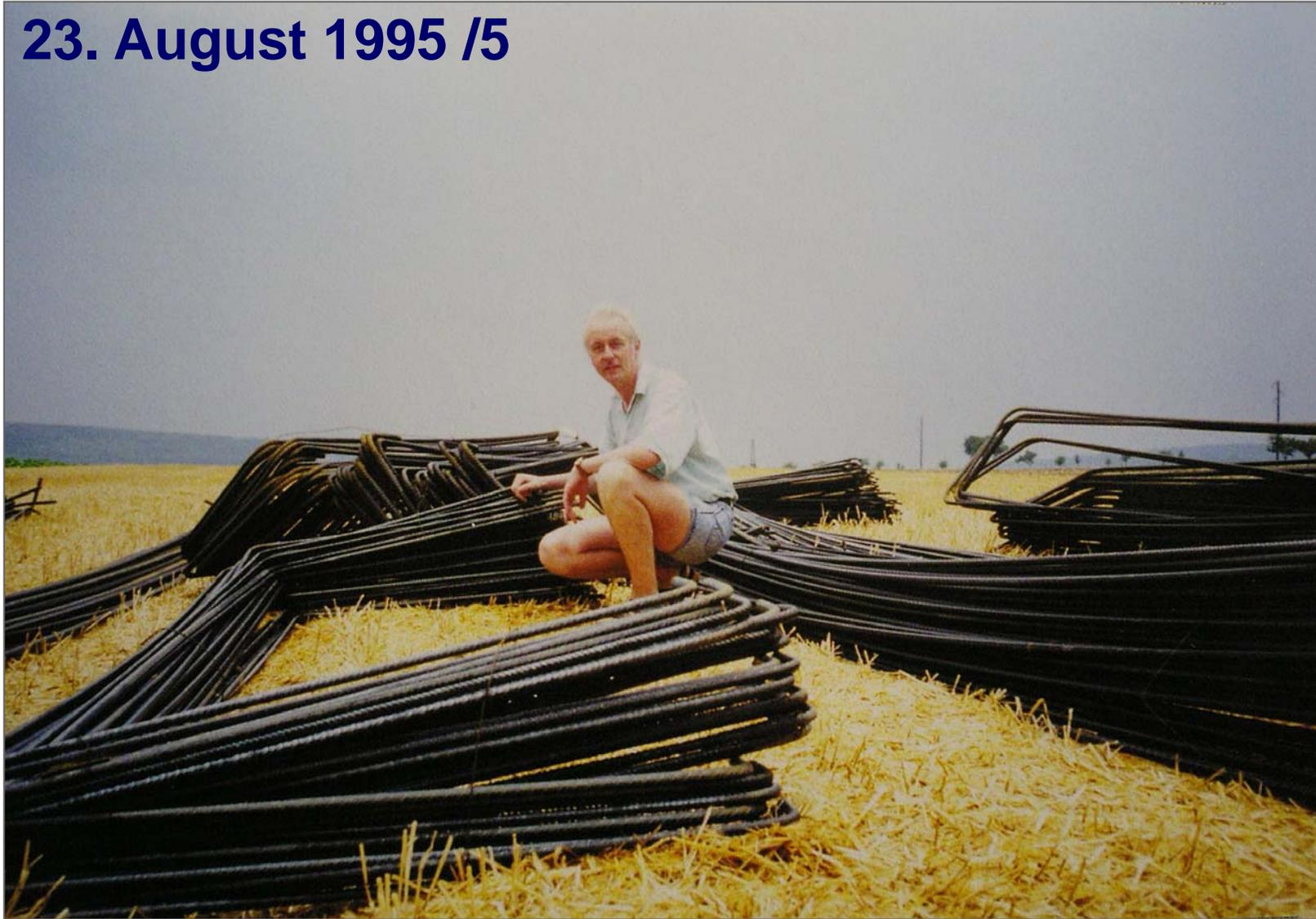
Die erste Lieferung ist angekommen! Fast 9 Tonnen Baustahl für die Bewehrung des Fundamentes liegen zum Einbau bereit.
