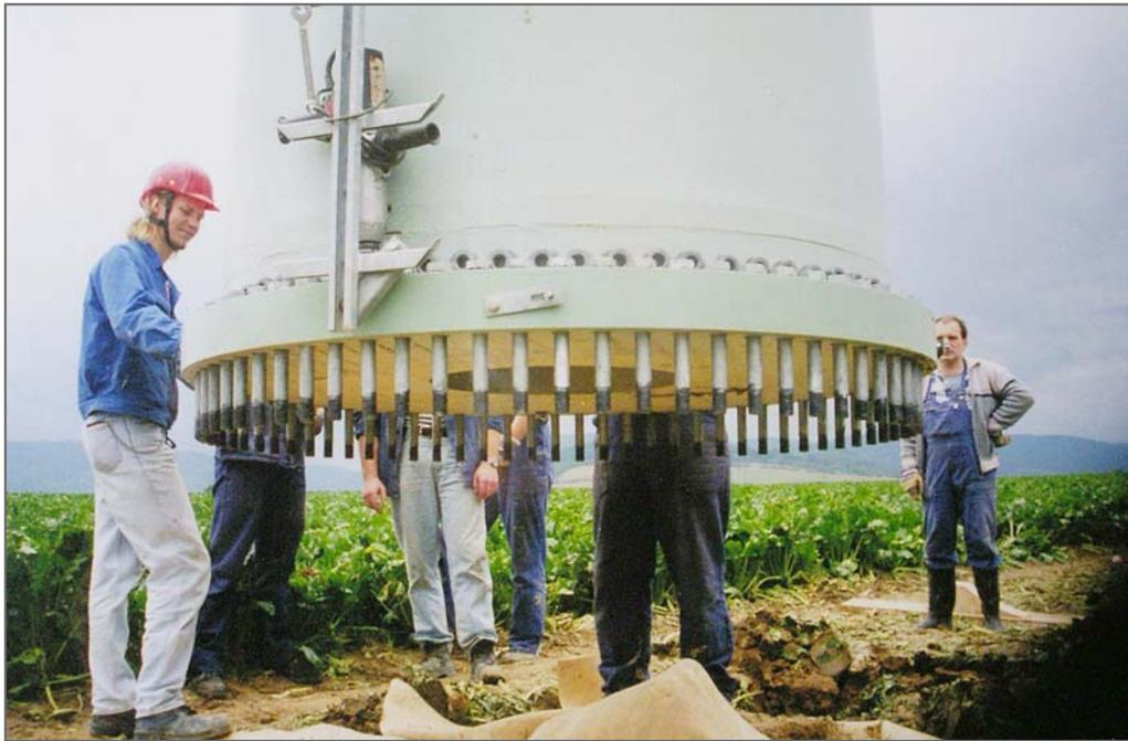
Hier wird der Turm bereits erwartet. Jetzt ist die ruhige Hand des Kranführers gefragt. Das Teil muß so präzise aufgesetzt werden, daß die Bolzen keinen Schaden nehmen.
