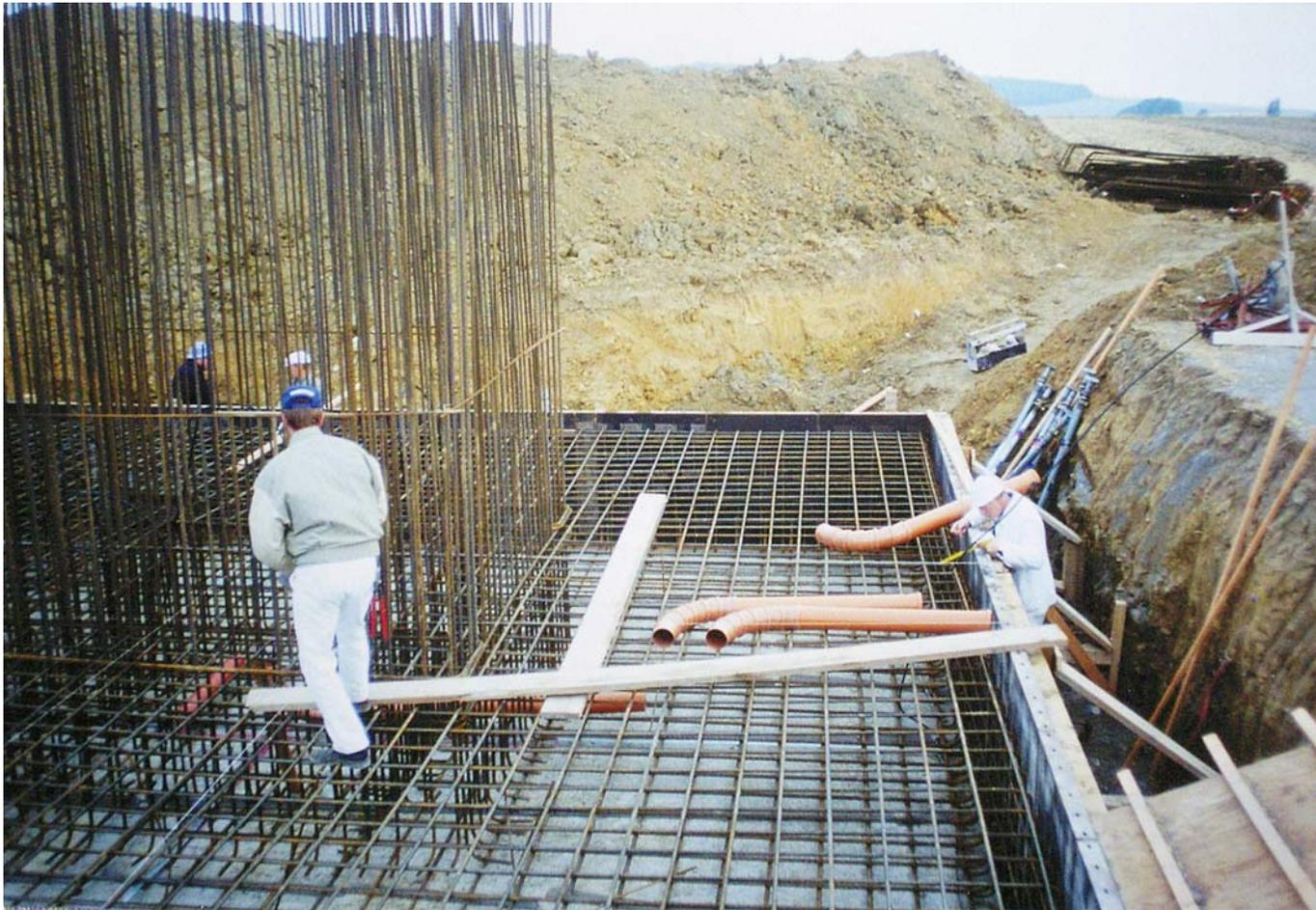
Die senkrechten Eisen der Köcherbewehrung sind komplett eingebaut. Jetzt werden noch die Leerrohre installiert, durch die die Kabel vom Turm durch das Fundament in die Trafostation gezogen werden sollen. Dabei ist Eile geboten, denn in zwei Stunden kommt der Beton ...
