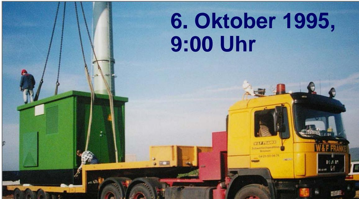
Die Trafostation ist eingetroffen. Sie enthält außer dem Trafo die Hochspannungs-, Schalt- und Meßeinrichtung und die Umformerschränke. Alles ist bereits komplett montiert.
