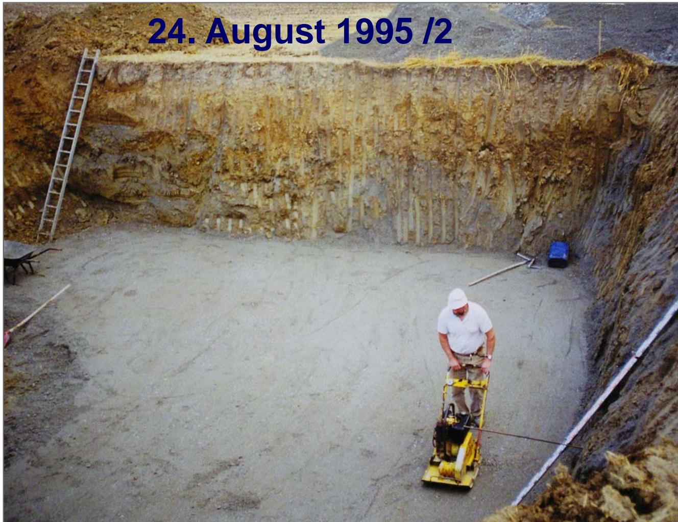
Der Bodengutachter hat die abgerüttelte Sohle der Baugrube begutachtet und abgenommen. Es wird damit begonnen, das Mineralgemisch für die Ausgleichsschicht lagenweise einzubringen und zu verdichten.
