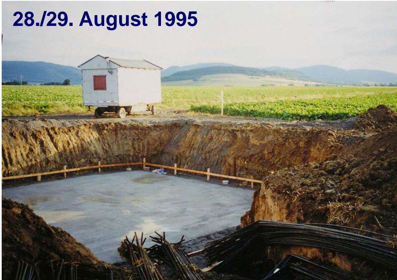
Die Ausgleichsschicht ist fertig gestellt. Um eine stabile Grundfläche für die Bewehrung und Schalung zu schaffen, ist eine Sauberkeitsschicht aus Beton gegossen worden. Der Baustahl ist zur Baugrube transportiert worden. Der Fundamentbau kann beginnen. Jetzt ist auch ein Bauwagen zur Stelle.
