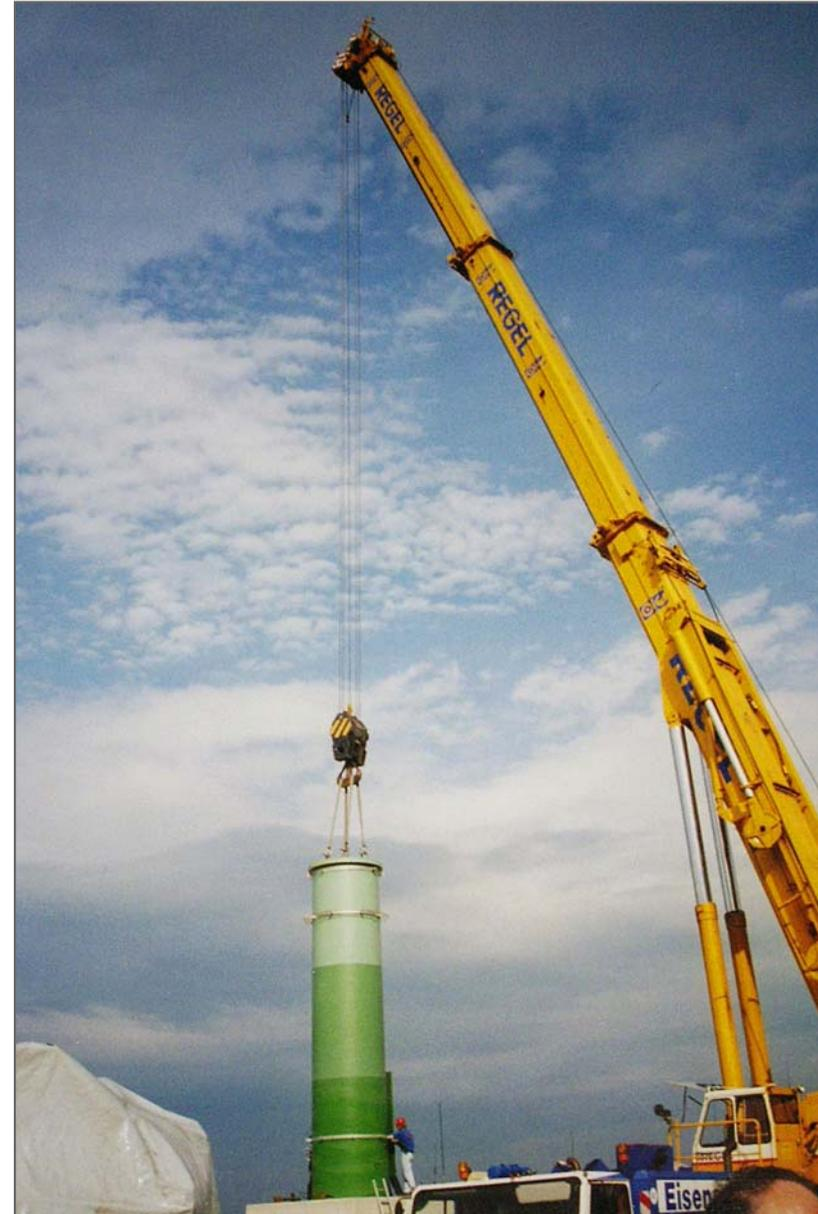
Das untere Turmteil wird in den Fundamentk6cher gesetzt und dort mit Spannvorrichtungen verkeilt. Hoffentlich spielt das Wetter weiter mit!
