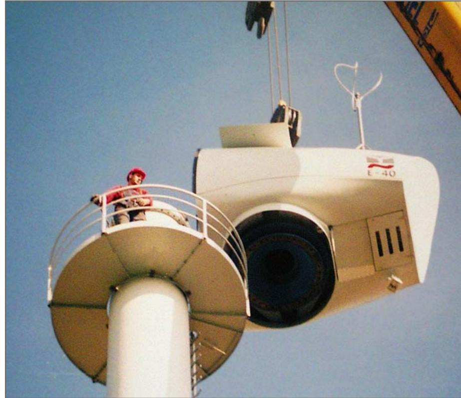
Das Maschinenhaus schwebt ein und wird sofort von den wartenden Monteuren befestigt. Anschließend werden die Kabel im Turm herabgelassen und durch die Leerrohre in die Trafostation gezogen.
