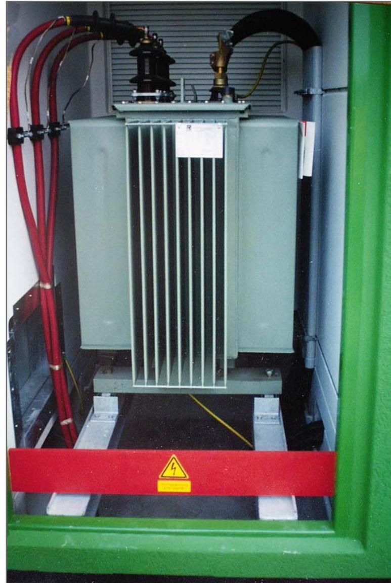
Der vormontierte Umformer und die Steuerelektronik werden betriebsbereit gemacht, der Transformator wird angeschlossen.
