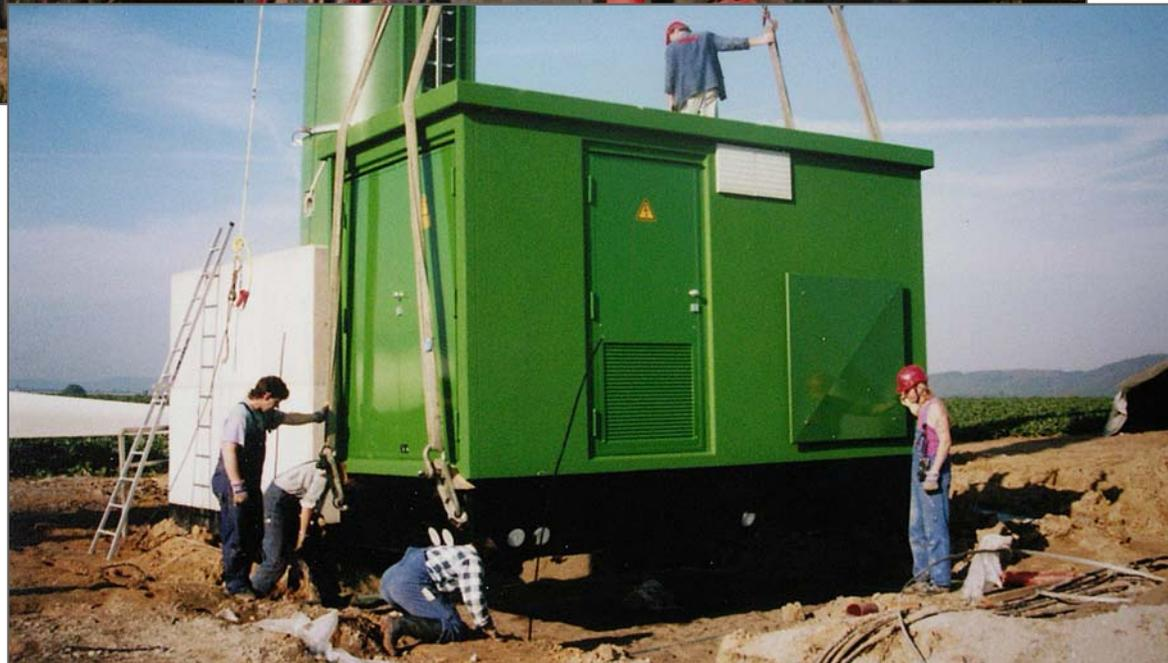
Die Station wird auf dem vorbereiteten Kiesbett abgesetzt.
