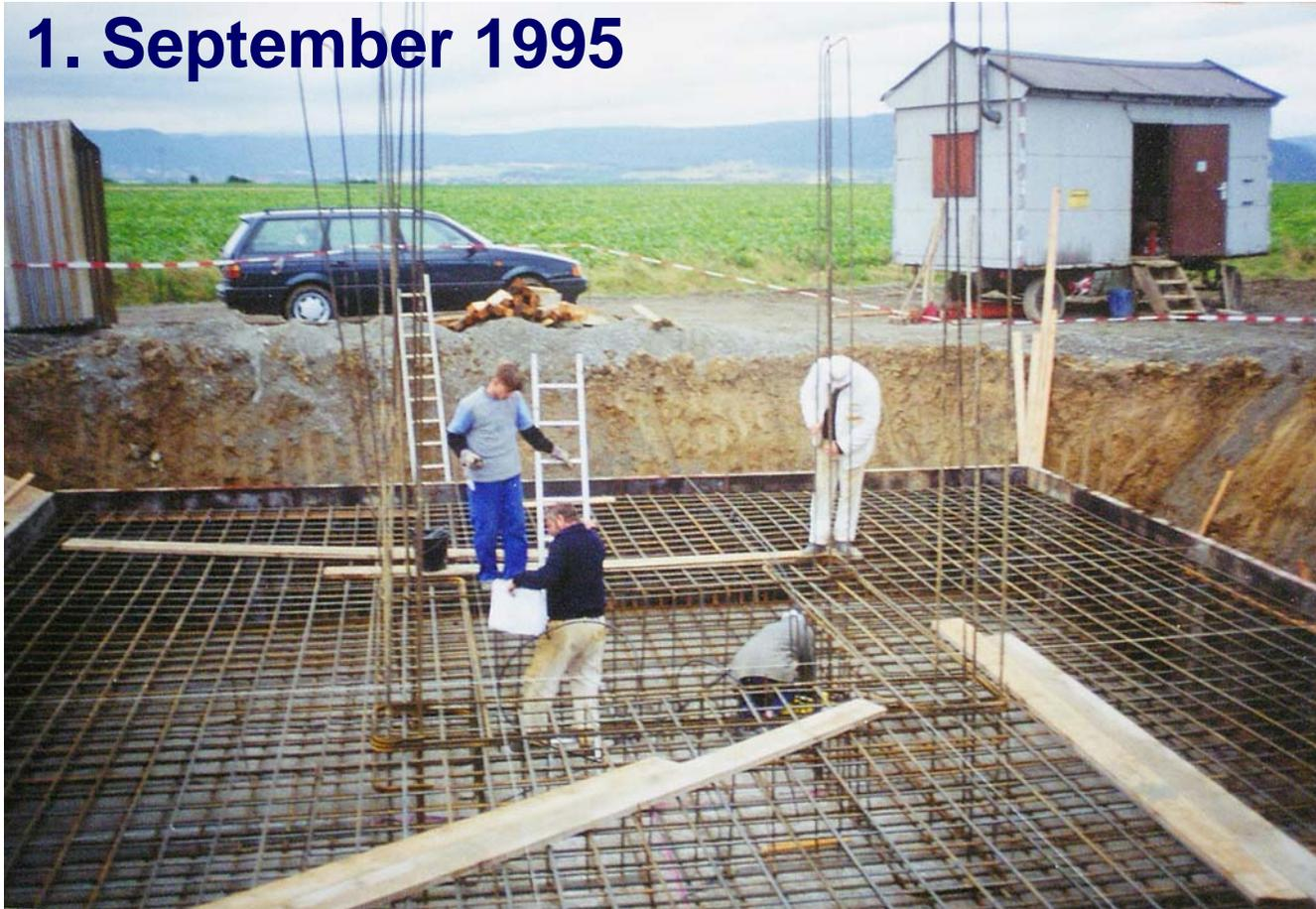
Hier wird mit dem Einbau der Eisen begonnen, die später einen Köcher bilden. In diesen Köcher soll der Turm hineingestellt und vergossen werden. Auf diese Weise werden die Biegekräfte des Turms zuverlässig in die Fundamentplatte geleitet.
