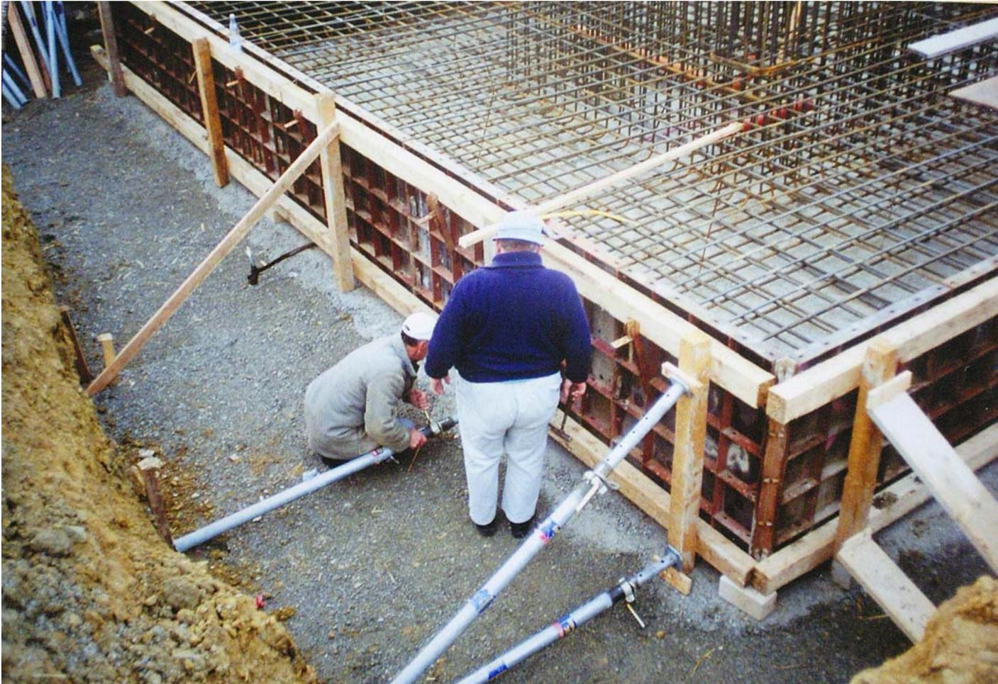
Die Schalung muß noch ausgesteift und abgestützt werden, damit sie den Betonmassen auch standhalten kann.
