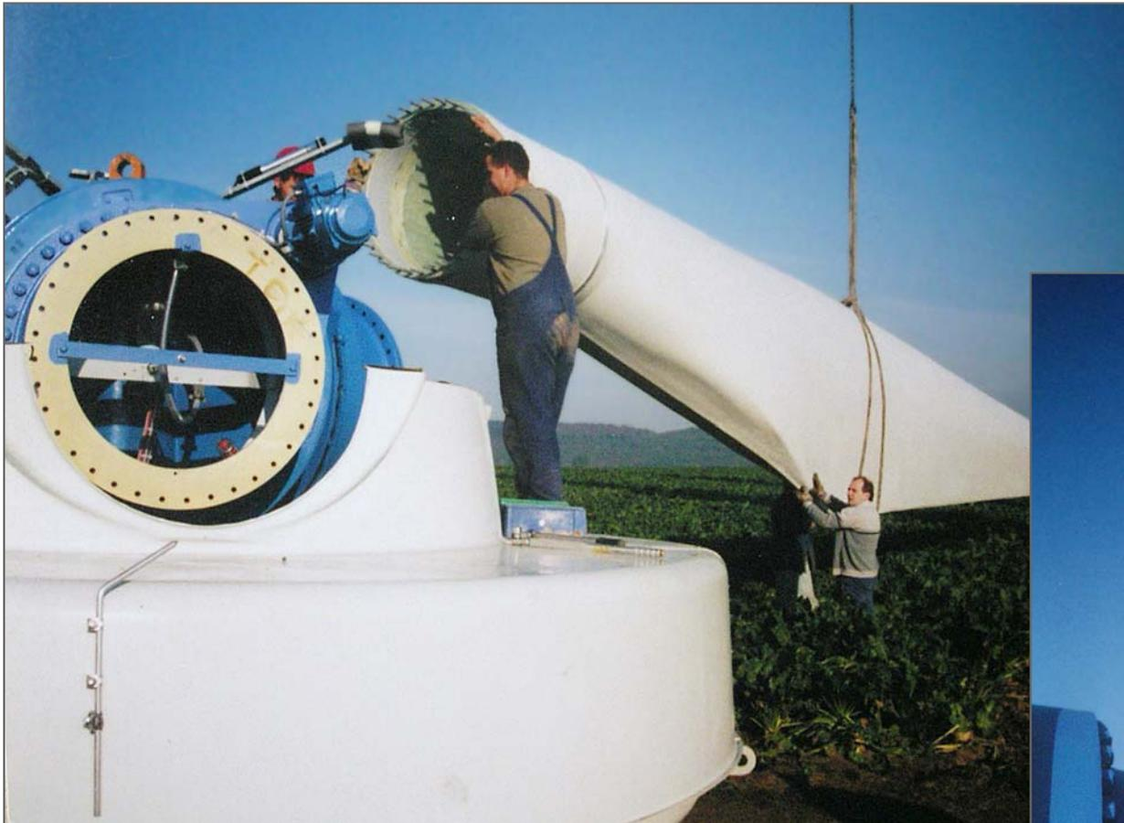
Die Rotorblätter werden vom LKW gehoben, in die richtige Position gedreht und mit der Generatornabe verschraubt.
