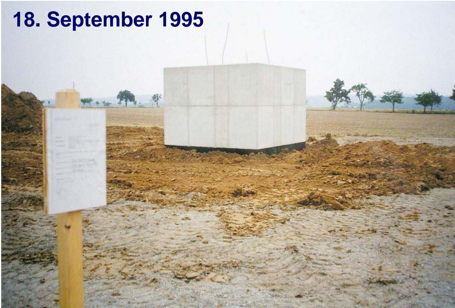
Nach Abdeckung der Fundamentplatte mit Erdreich ist das Fundament fertig. Zum Glück konnte diese Arbeit bei trockenem Wetter zuende gebracht werden.
