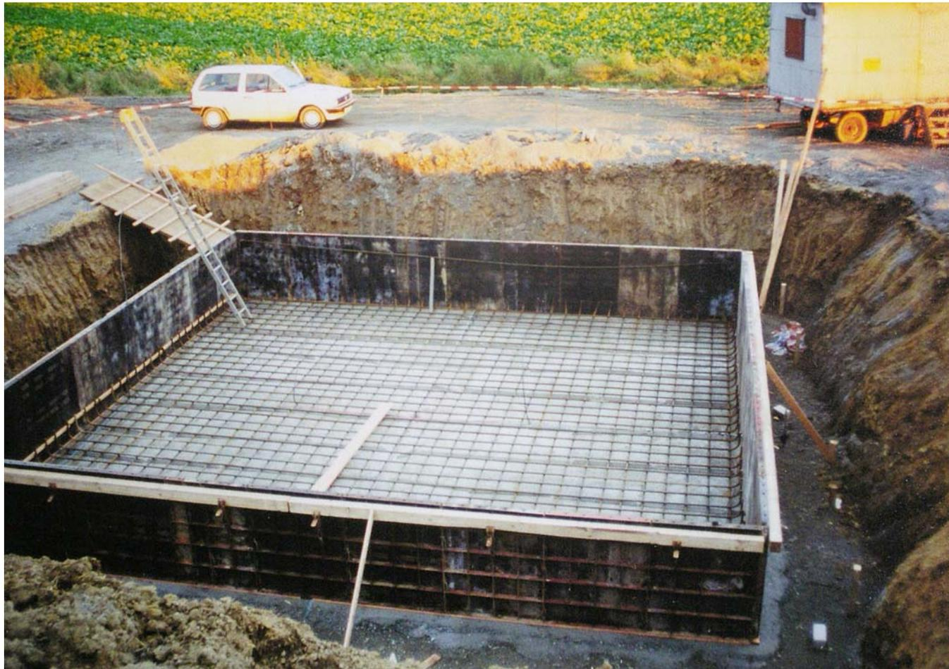
Die untere Bewehrung ist eingebaut, die Schalung der Fundamentplatte ist aufgestellt. Die Fundamentplatte mißt 8,9 mal 8,9 m und wird 1,2 m hoch.
