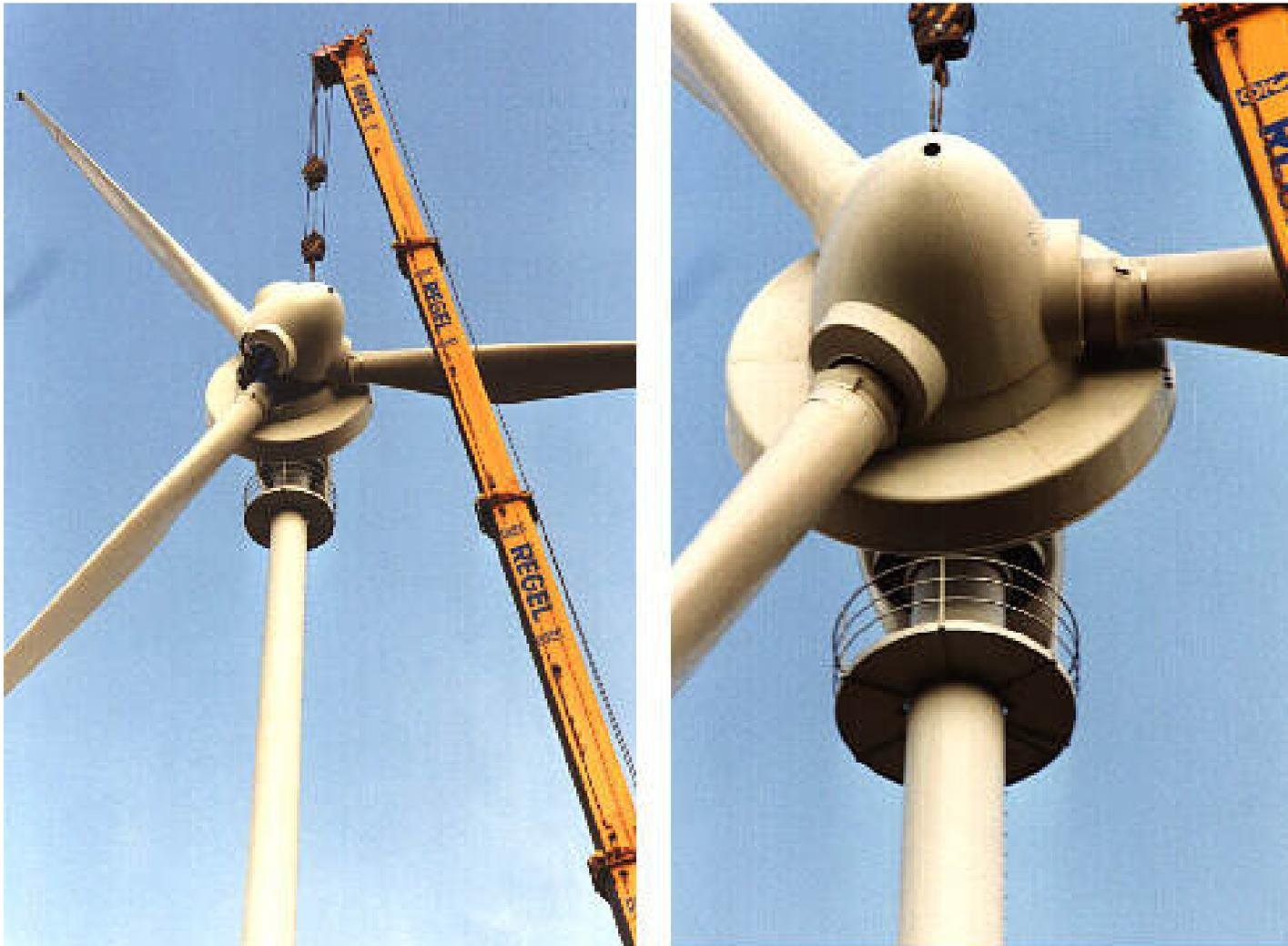
Als letztes wird die Nabenverkleidung montiert.
