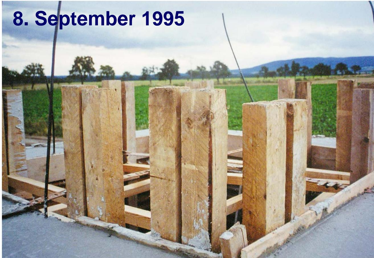
Nun ist auch der Köcher mit hochfestem, wasserdichtem Beton gegossen worden. Die Mitarbeiter der Firma Lindemann haben durch Ihren Einsatz maßgeblich dazu beigetragen, daß das Fundament termingerecht gegossen werden konnte. Bis zum Aufstellungstermin bleiben jetzt gerade die erforderlichen 4 Wochen Aushärtezeit.
