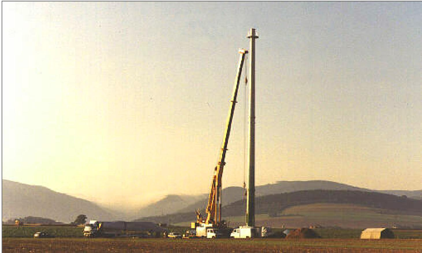
Der Turm ist bereit für die Montage der Maschine. Der LKW mit den Rotorblättern ist bereits gestern abend eingetroffen.
