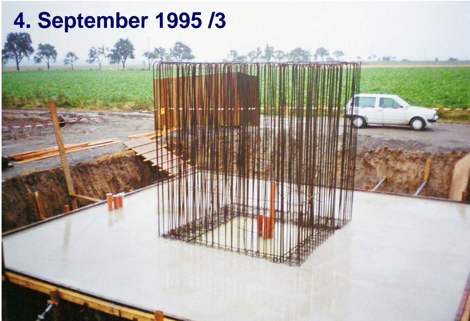
Die Fundamentplatte ist gegossen worden, 80 Kubikmeter Beton sind verbaut. Hier kommt uns das Regenwetter einmal entgegen: Die Nässe unterstützt das langsame Abbinden ohne Schwundrisse.
